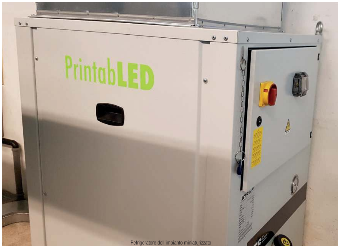
Refrigeratore dell'impianto miniaturizzato
